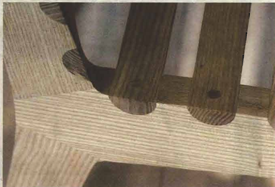
MED OMHU. På dette detaljefoto af 'Menuet'-stolen ser man tydeligt de meget omhyggeligt udførte samlinger mellem sædets ribber og sidestykket.
